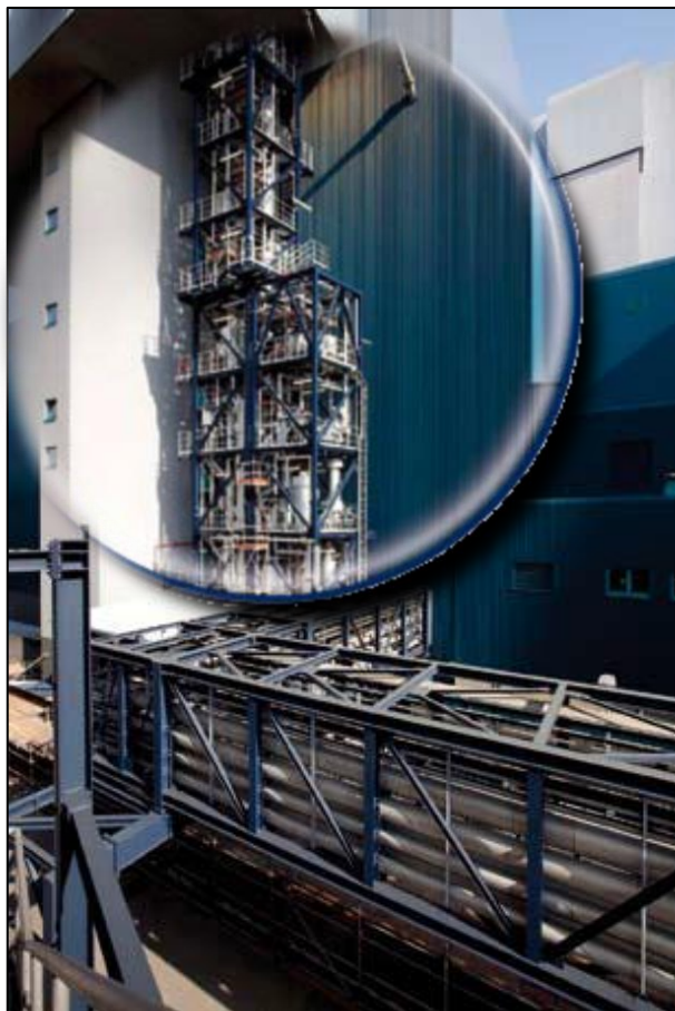
Obr. 14 Systém zachytávání CO 2 v Niederaussemu (17)
